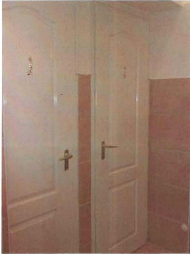
Felújított vizesblokk a Petőfiben
